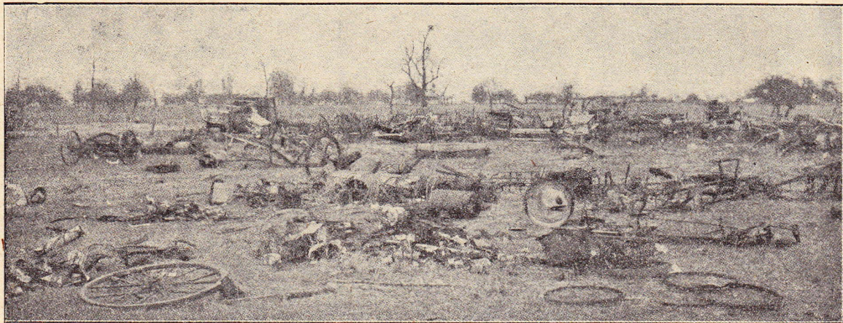
Les Boches détruisirent même les arbres et les instruments aratoires.
